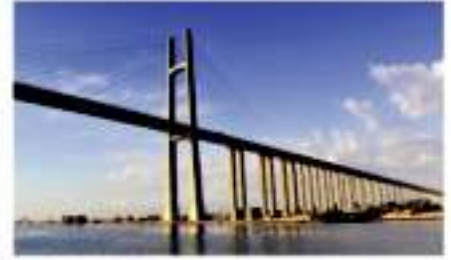
نستخدم الصلب لبناء الجسور
