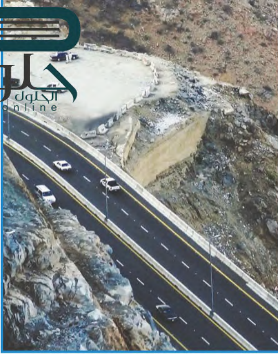
هذا الطريق سطح مائل
