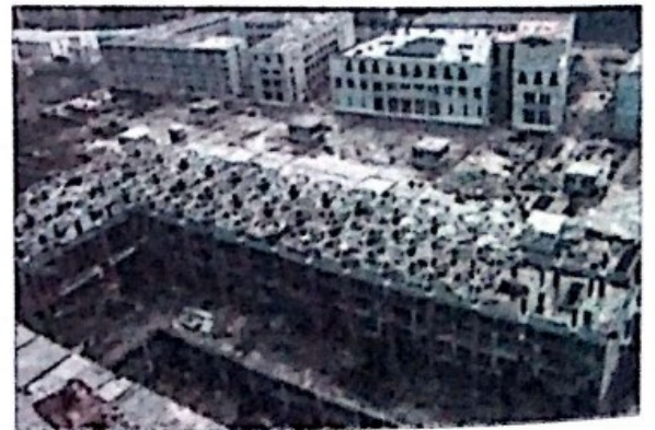
المسجد الكبير بالجزائر العاصمة في طور البناء المضاد للزلازل
