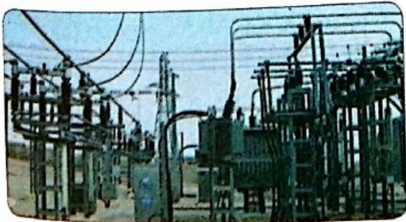
2. محطة توليد الكهرباء.
